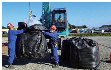
仮置場での積込作業
