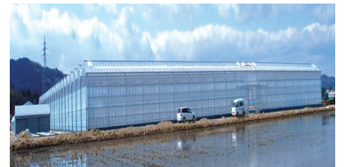
実証研究施設全体の外観
